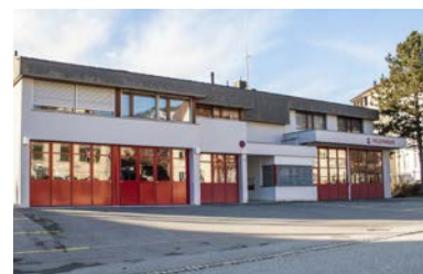
Entspricht nicht mehr den heutigen Vorgaben: Bestehendes Feuerwehrdepot an der Schulhausstrasse.
