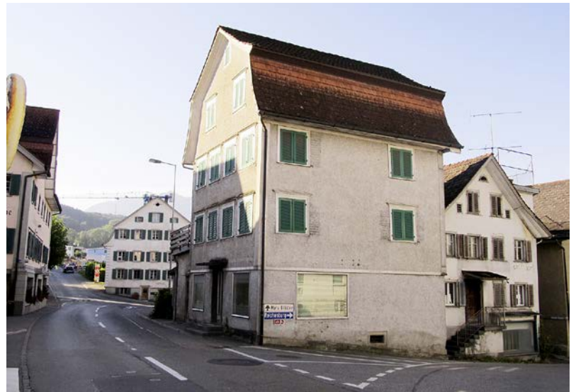
Das Bürdelhaus im Dorfczentrum von Benken.
